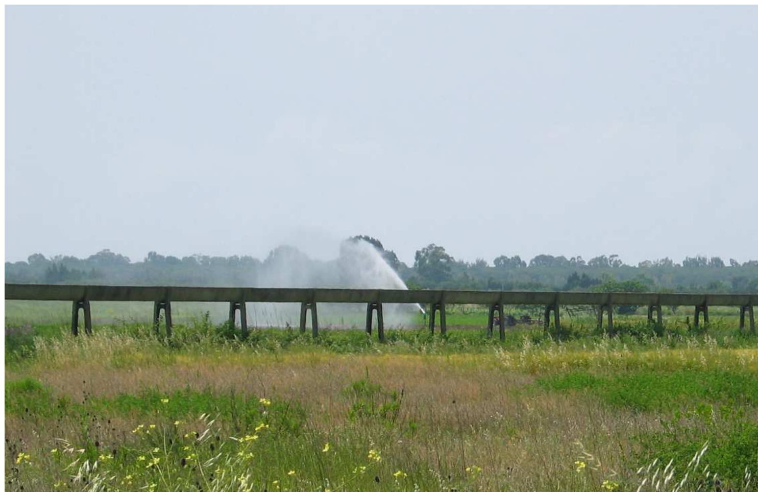
Piana di Lamezia - Canalette ed irrigatori a pioggia
