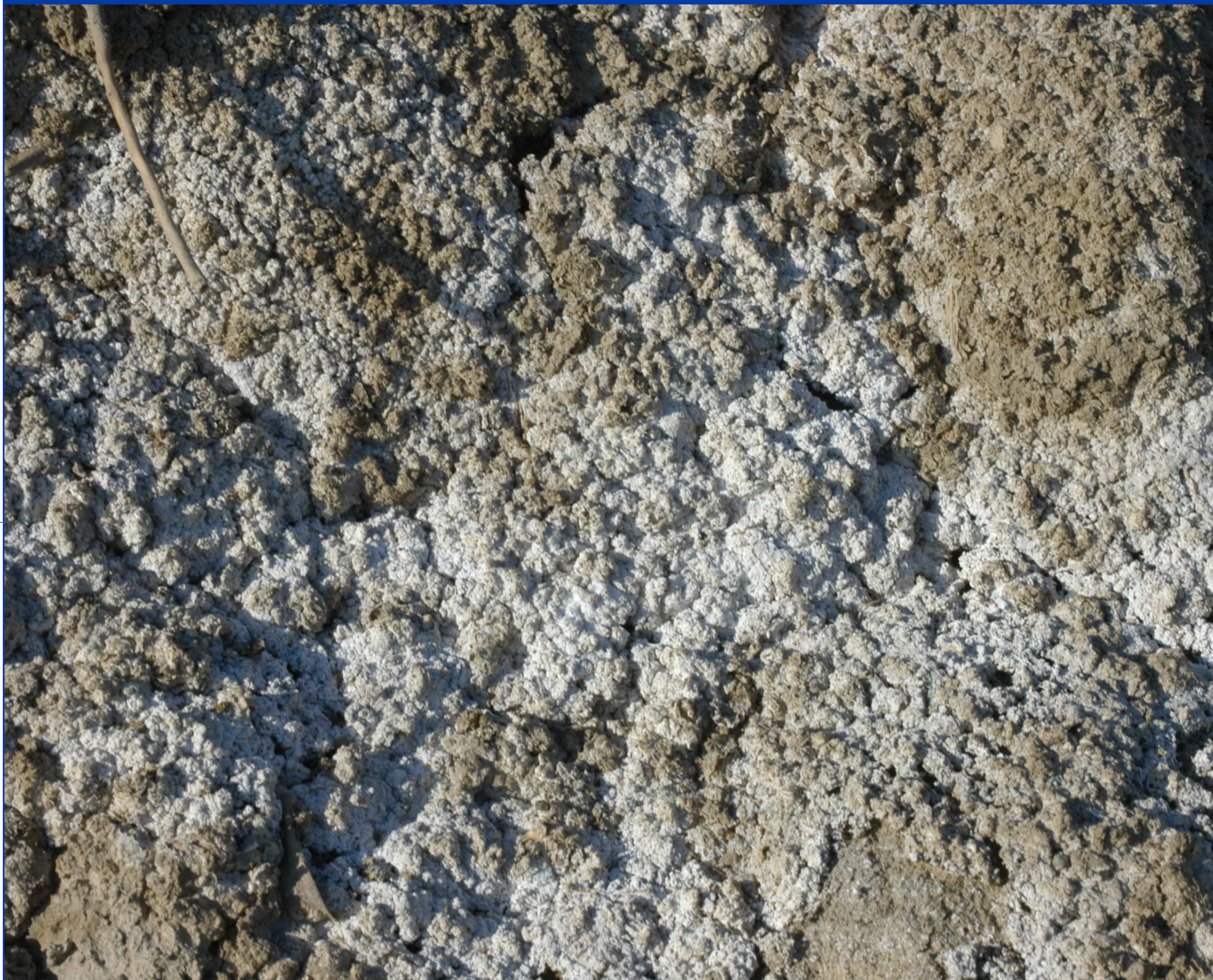
Efflorescenza legate all'uso di acque ad elevata salinità
